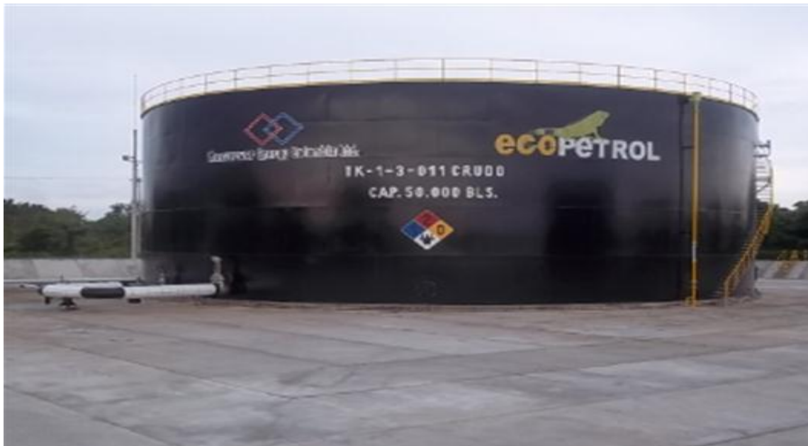
Figura 2. Tanque de almacenamiento campo moriche
