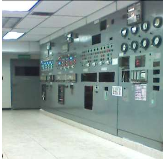
Figura 16. Antiguo tablero de control neumático de la Central del Norte, Refinería Barrancabermeja.
