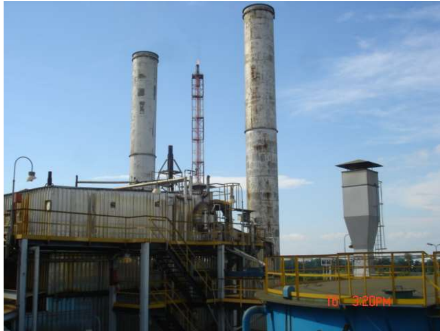
Figura 14. Costado sur de la B-2404, Refinería Barrancabermeja
