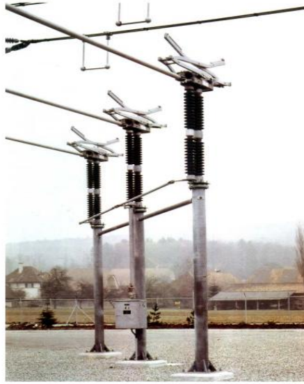
Figura 3.5 Seccionadores de Pantógrafo
