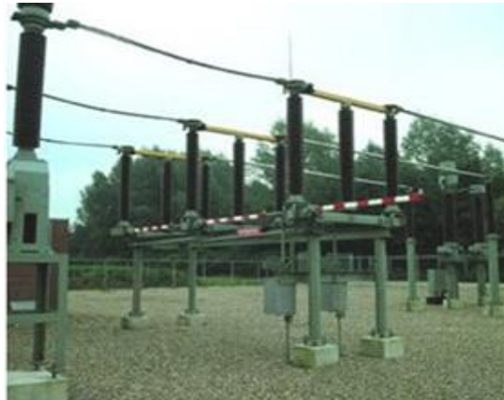
Figura 3.4. Seccionadores de columnas giratorias
