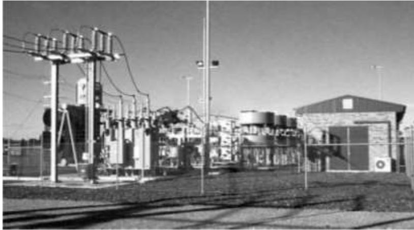
Ilustración 13. SVC fabricado por Alstom de +30/-25MVar en 66kV.
