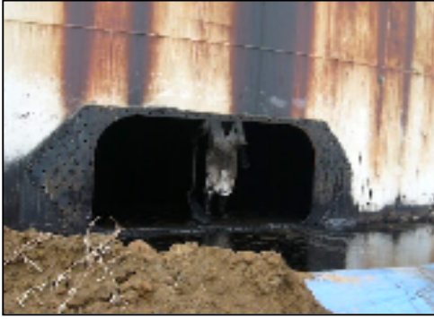
Foto 9. Remoción Fondos Tanque
