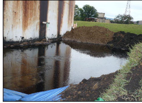
Foto 10. Remoción Fondos Tanque
