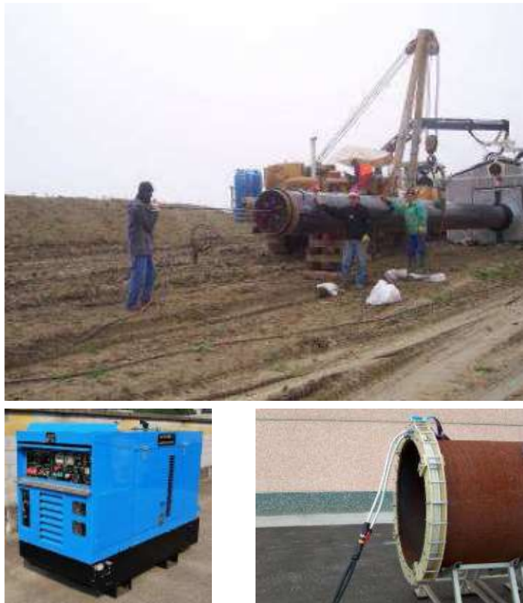
FIGURA 23. PRECALENTAMIENTO
