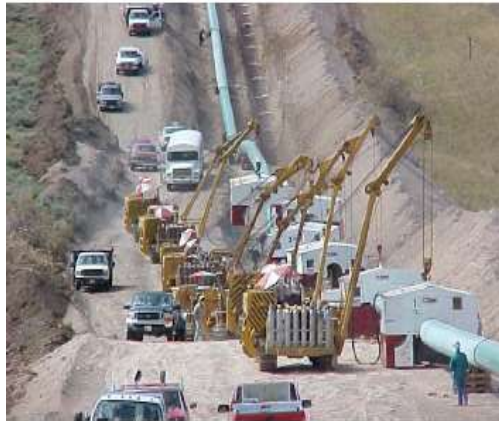
FIGURA 3. FRENTE DE SOLDADURA EN LA CONSTRUCCIÓN DE UN OLEODUCTO
