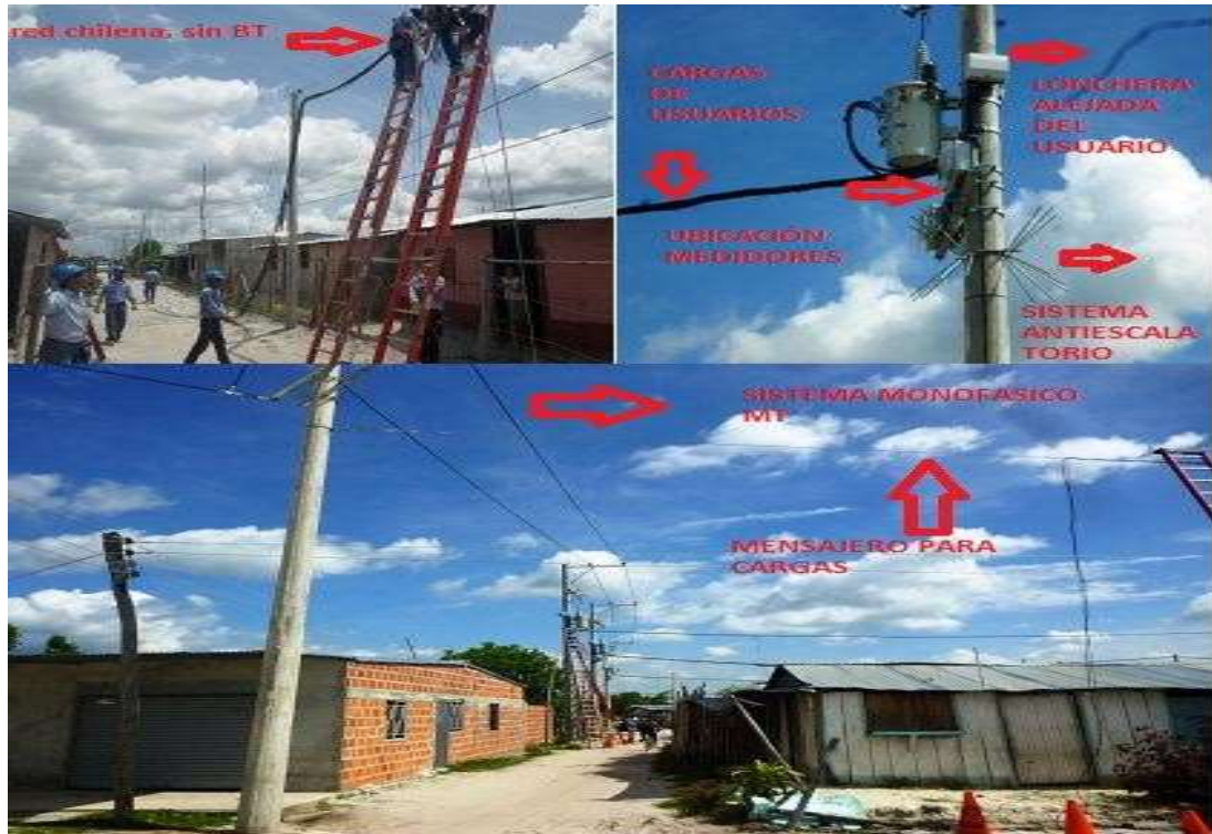
Figura N° 26. Construcción de media tensión ya que la red chilena no cuenta de baja tensión.
