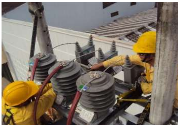
Figura N° 10. Instalación de transformadores de corriente y tensión en línea de 34.5 Kv.
