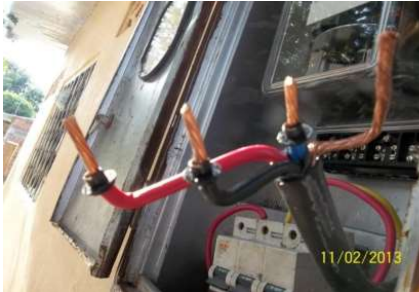
Figura N° 35. Instalación de ojales en bornera del equipo de medida.
