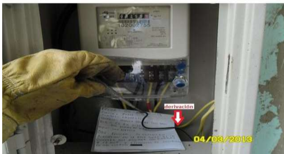
Figura N° 19. Línea directa antes del medidor.
