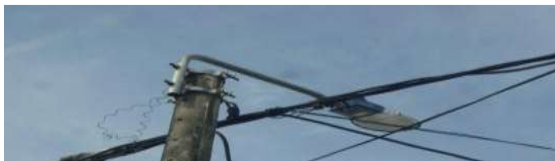
Figura N° 34. Modificación de alambre por cable en la conexión de A.P.
