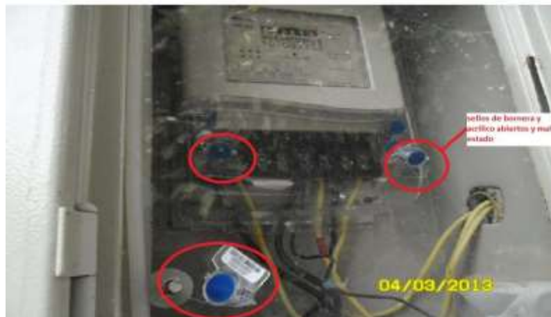
Figura N° 20. Sellos rotos y con signos de manipulación.
