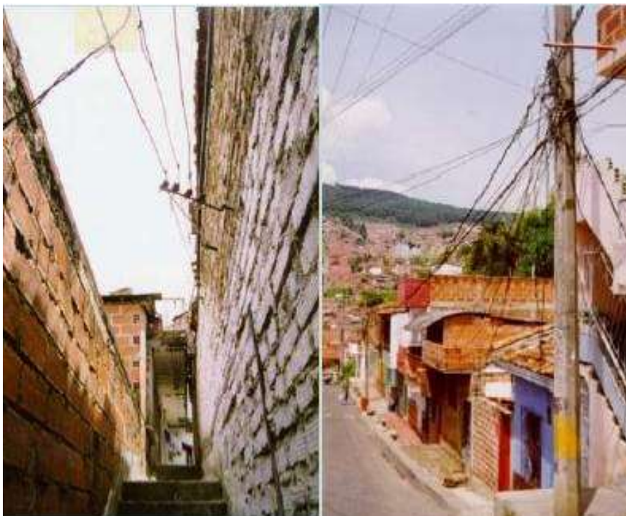
Figura N° 22. Transformador de pérdidas altas debido a sus redes vulnerables.
