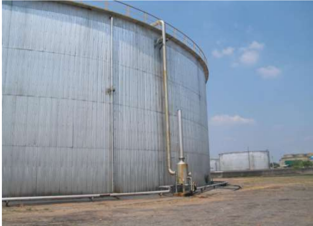
Figura 7. K2502 Tanque caliente con fondos de vacío de la GRB.
