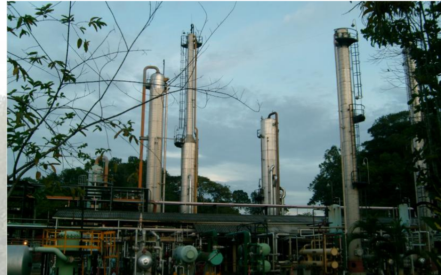
Vista General de la Planta
