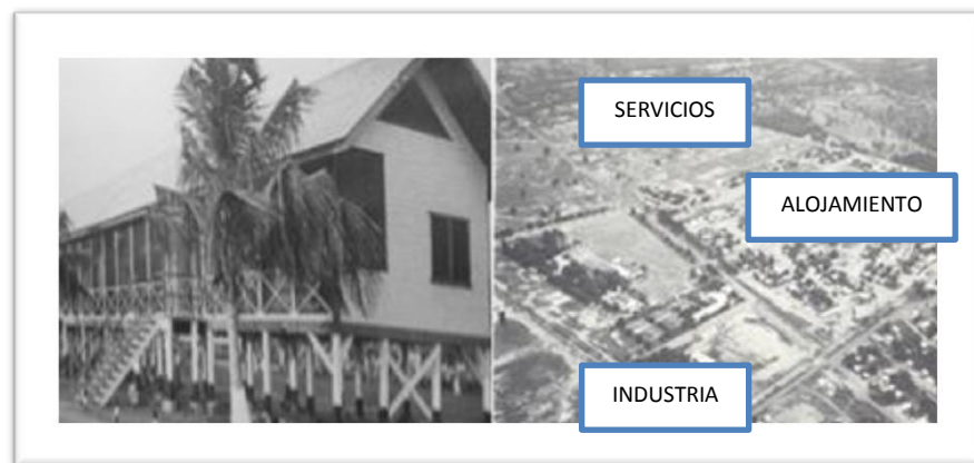
Figura. 4. Asentamiento Urbano Petrolero, ciudad Dormitorio Ciudad Industrial 1928 Venezuela 5
