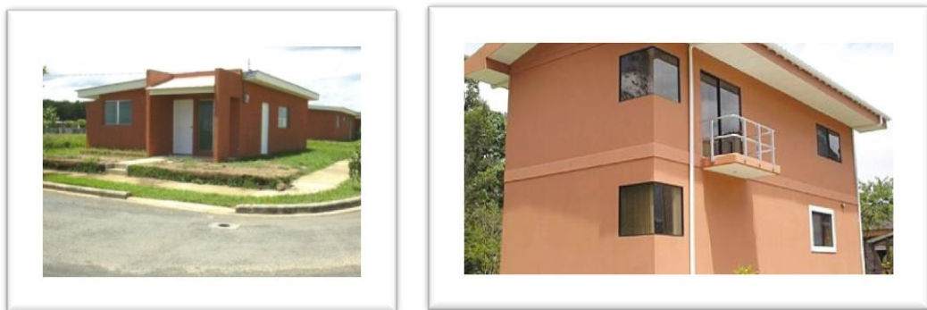
Figura 10. Ejemplos de alojamiento en Plycem como material constructivo
