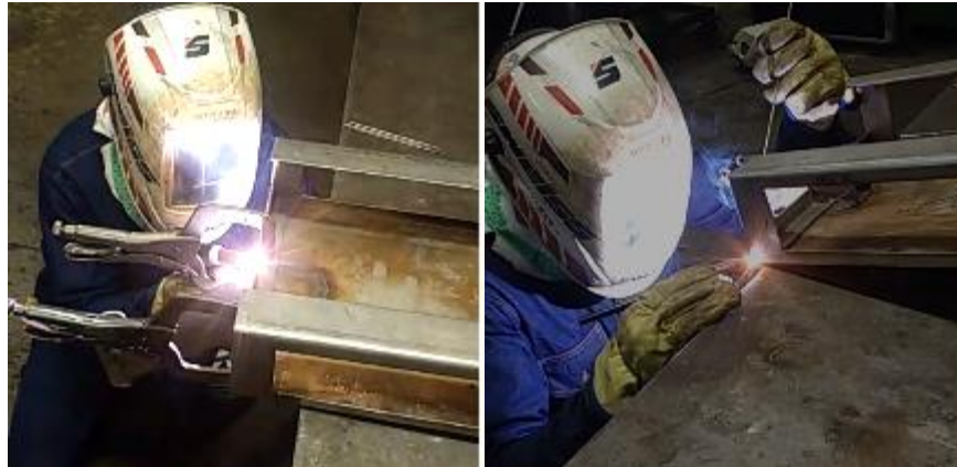
Figura 39. Soldadura de soportes estructurales con argón.
