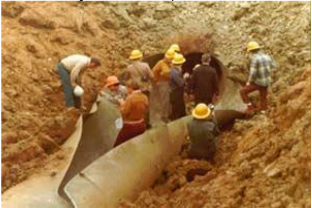
Figura 9. Actividades de reparación de tubería
