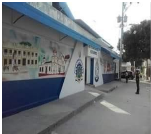
Fotografía 1 Fachada de la I.E. Vista Hermosa
