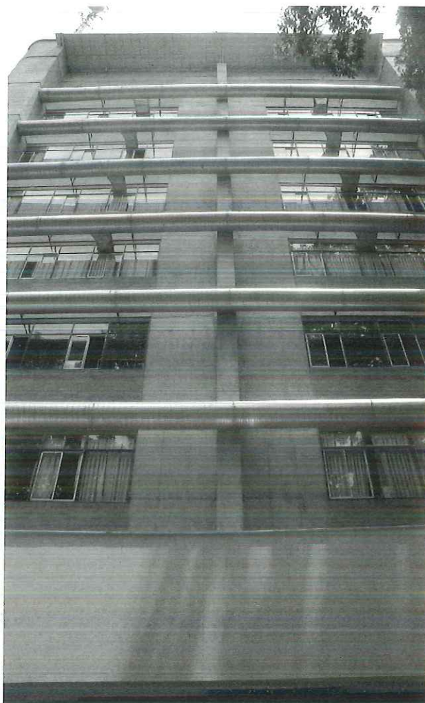
Edificio de Ingenierías UNAB
