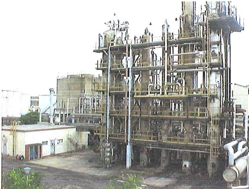
➤ **Sección de absorción:** Ésta sección busca recuperar la mayor cantidad posible de fenol de la corriente de vapor fenólico que se inyecta a la torre, donde la corriente de carga pasa en contracorriente, permitiendo un contacto íntimo entre sus moléculas y haciendo posible la transferencia de masa.
