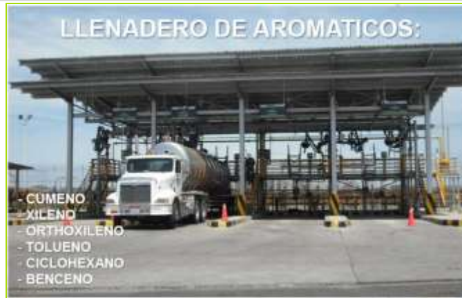
Figura 7. Llenadero de Aromáticos de Ecopetrol S.A en Barrancabermeja
