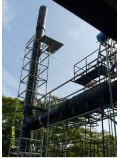
Figura 7. Chimenea Del Centro De Generación Tibú
